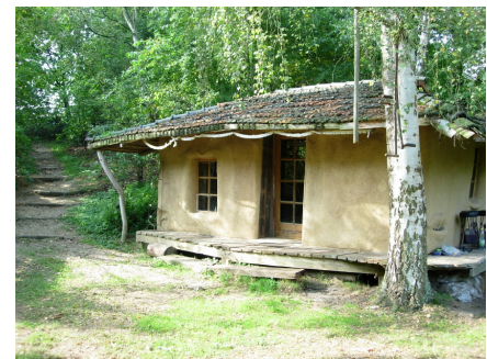
Ein mit Lehm verputztes Strohhallenhaus in Swalmen, Niederlande
